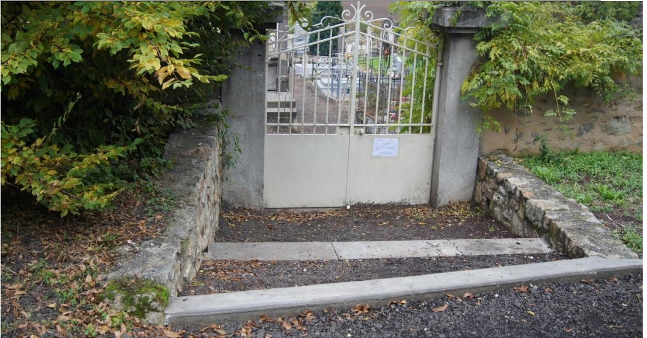
**Une marche en béton** a été réalisée par les employés municipaux afin de stopper l'écoulement important des eaux pluviales qui entraînait la détérioration progressive de l'intérieur du cimetière.
