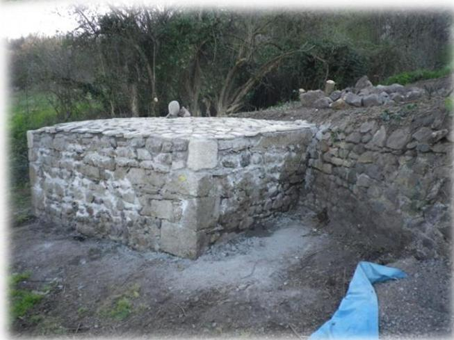
La rénovation s'est poursuivie par le rejointoiement des pierres et par le pavage des abords.
